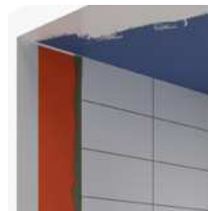
BILD N – Tak målat efter platsättning
